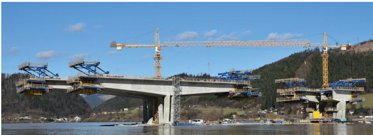
Obr.7 Fotografie z výstavby NK pomocou letmej betonáže na TC4.
