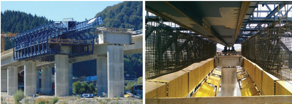
Obr.5 Fotografie z výstavby NK výsuvnou skružov Strukturás na TC2.
