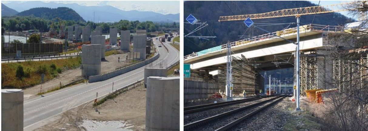
Obr. 4 Fotografie z výstavby TC1
