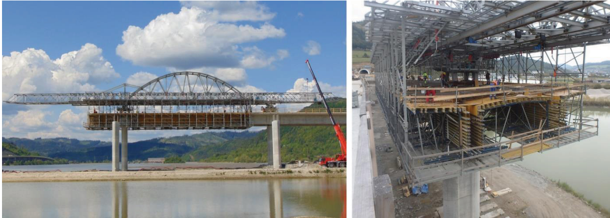
Obr.6 Fotografie z výstavby NK výsuvnou skružou BERD na TC4.
